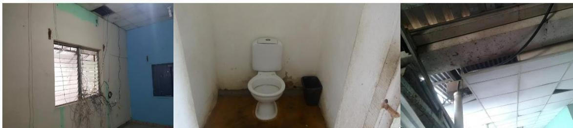
Durante la presente inspección, se observó la infraestructura dañada y obsoleta. Se observaron deficiencias en los pisos, paredes y techos deteriorados, tuberías cercanas a espacios de atención a derechohabientes, puertas en mal estado y elevadores que no se encontraban en funcionamiento.
