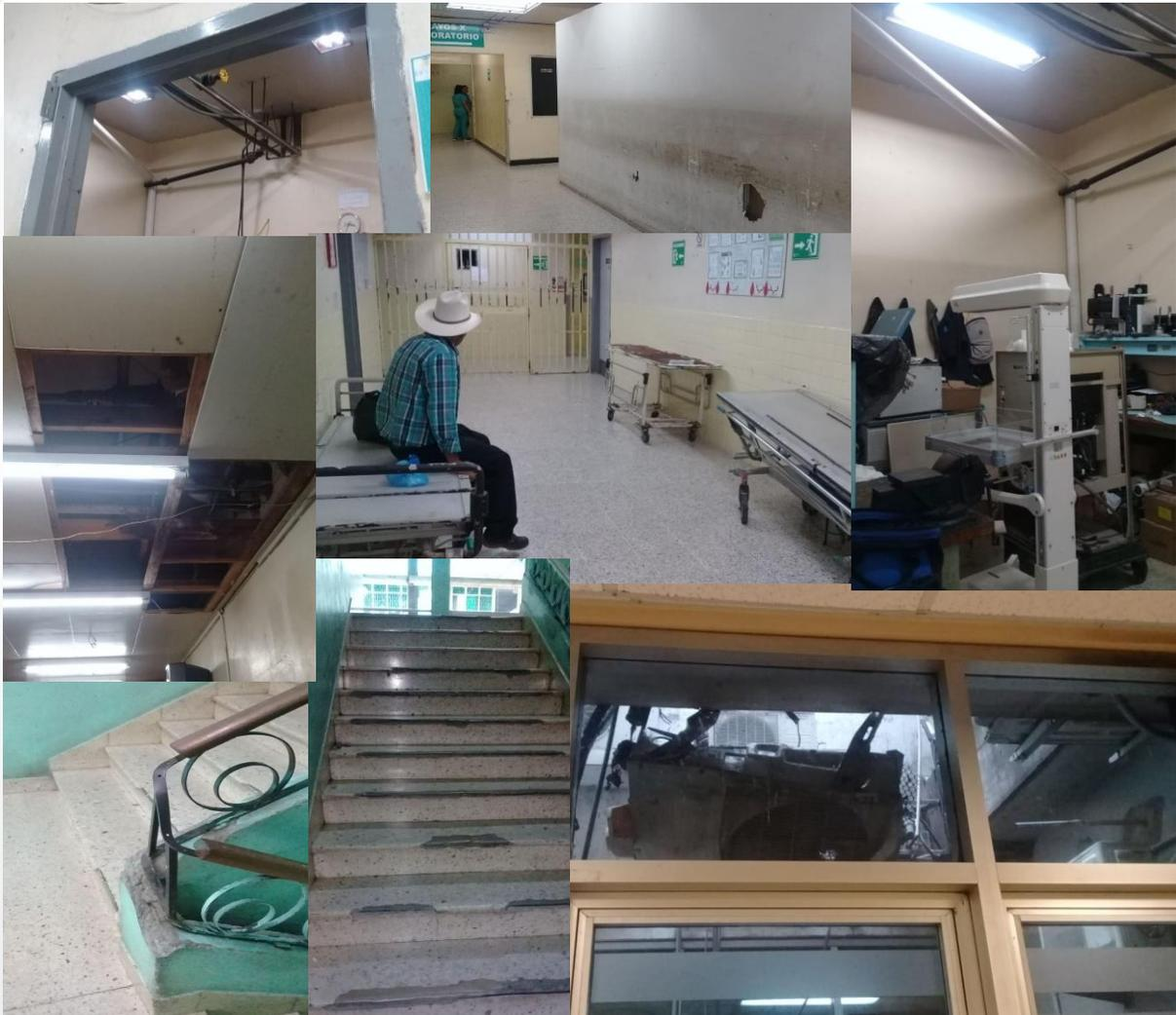
Pisos, techos, gradas, paredes y ventanas visiblemente deterioradas, tuberías visibles y expuestas, y mobiliario obsoleto, son algunos de los aspectos que se observaron en el Hospital Escuela Universitario, y que, con el paso del tiempo, poco o nada se ha mejorado.
